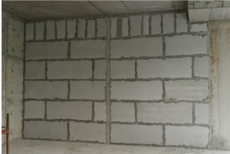
Hình 10 - Dự án Balestier Tower (Singapore) (tận dụng miếng panel cắt nhỏ cho hàng trên cùng)
