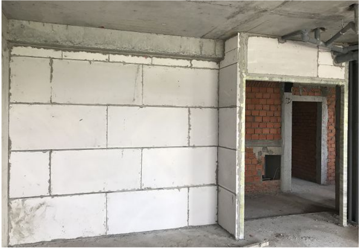
Hình 12 - Mockup Dự án Kikyo Residence (sử dụng gạch AAC cho hàng trên cùng)
