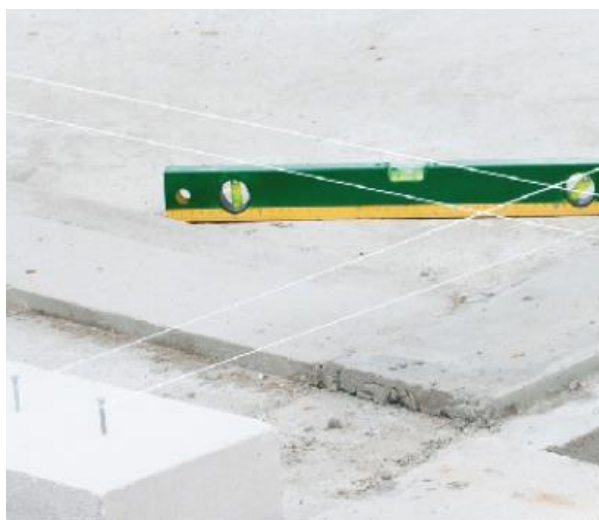
Trát lớp vữa xây tại chân tường tạo bề mặt phẳng, bề mặt lớp vữa lớn hơn chiều dày gạch mỗi bên 5 cm
