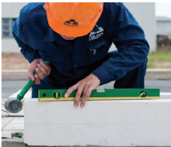
Đặt viên gạch đầu tiên tại vị trí góc tường trùng đường biên đã căn chỉnh, dùng búa cao su gõ cân chỉnh gạch
