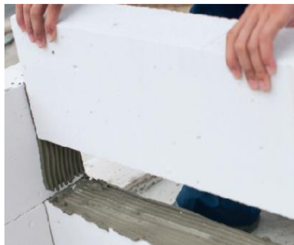
Lắp lại với những viên gạch tiếp theo và các hàng gạch kế tiếp.
