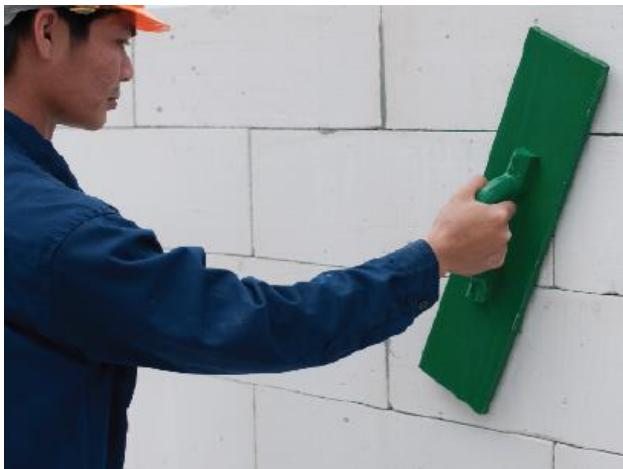
Sử dụng vữa xây chuyên dụng trám đầy các vị trí mạch vữa, khuyết mẻ. Sử dụng bàn chà hoặc máy mài xử lý sai số bề mặt trước khi tô.
