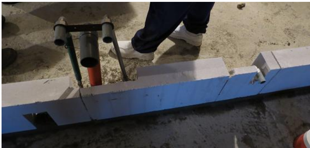
Hình 3: Sử dụng gạch chống thấm AAC EBLOCK cho việc chống thấm thấu ngược
