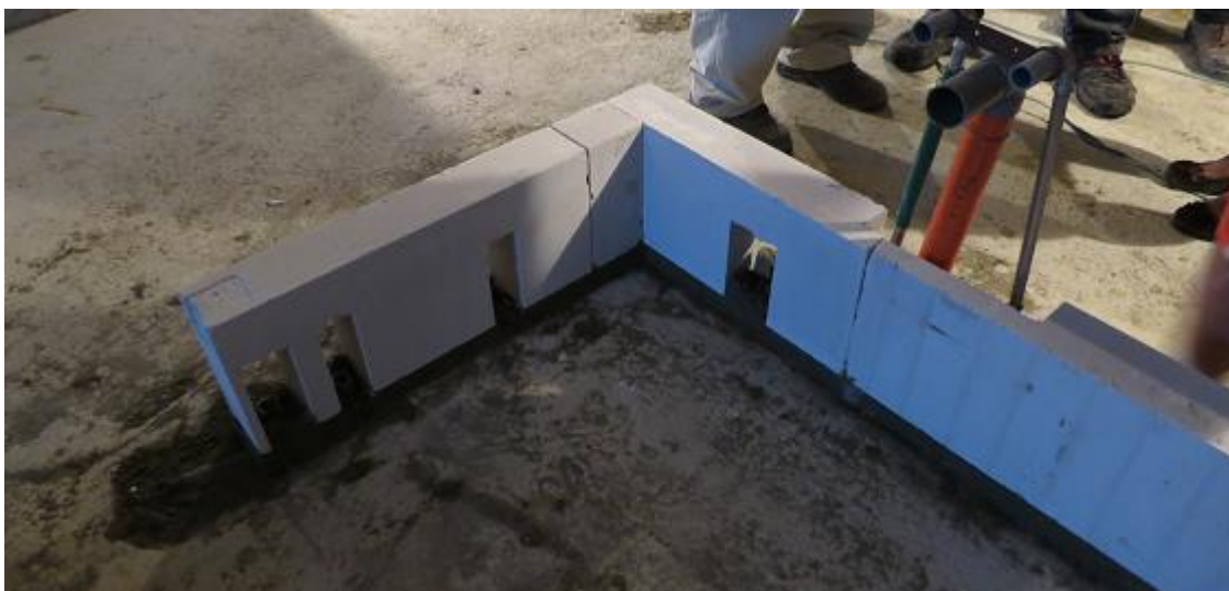
Hình 4: Sử dụng gạch chống thấm AAC EBLOCK cho việc chống thấm thấu ngược
