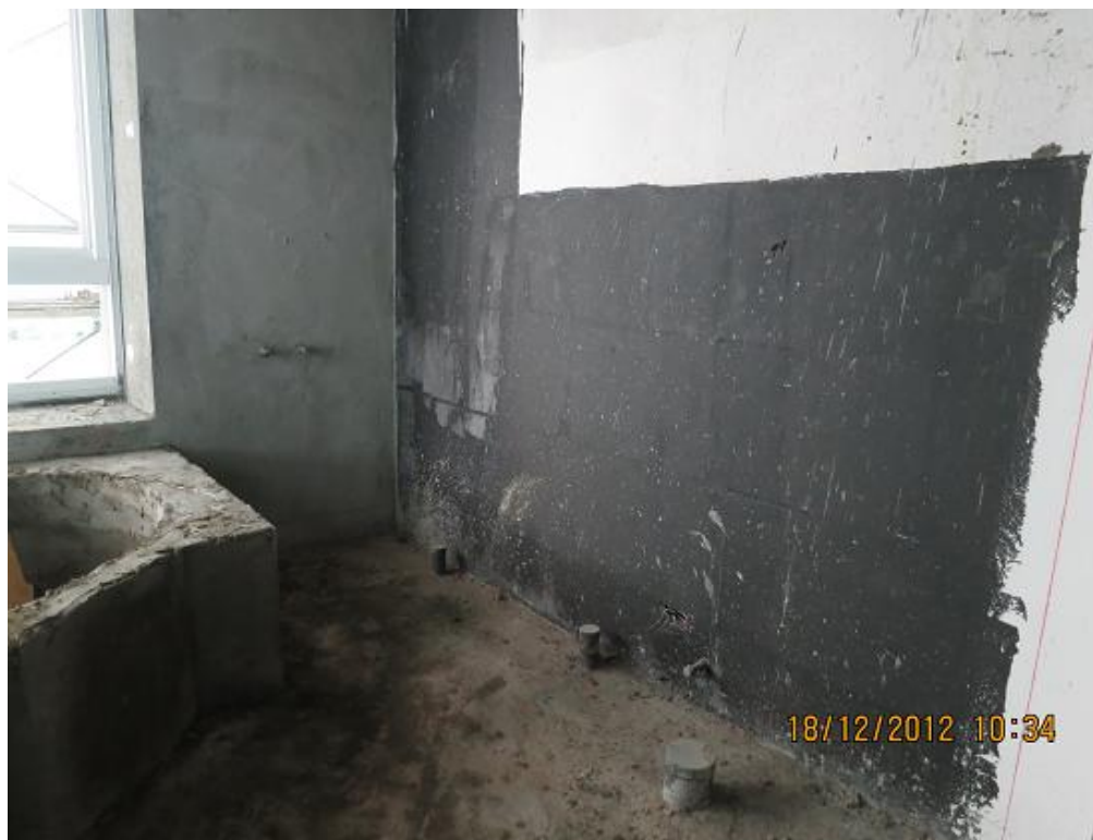
Hình 5: Chống thấm cho tường AAC EBLOCK ở các công trình xây dựng Đài Loan
