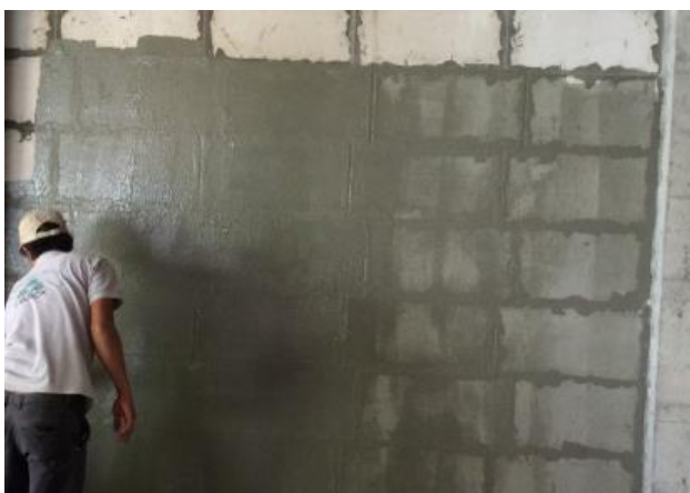
Lăn lớp mỏng (bằng cọ, rulo,...) vữa lót EBH - 401 trực tiếp lên trên bề mặt gạch
