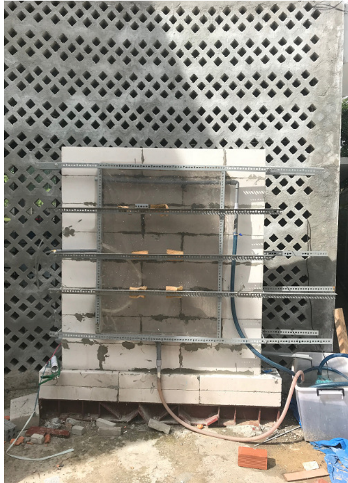
Hình 2: Mẫu tường gạch AAC thí nghiệm thấm theo ASTM E514
